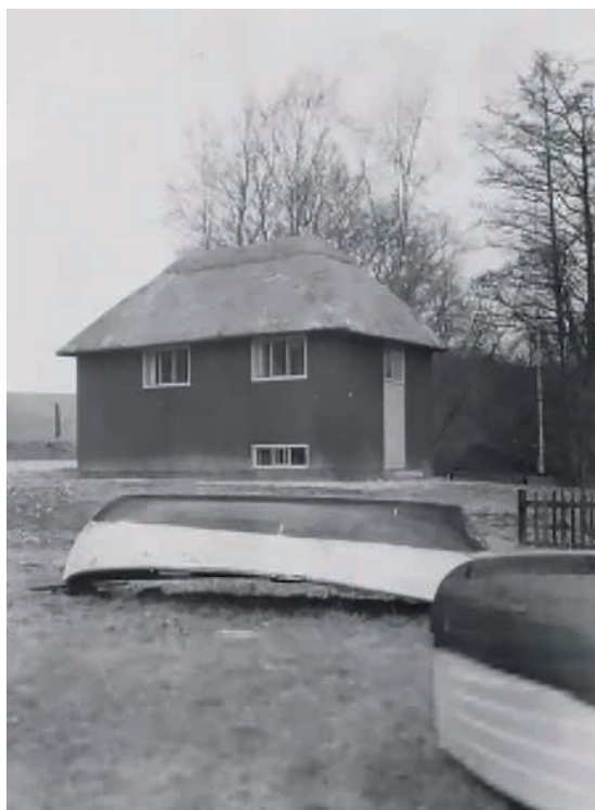
Hans Georg Skovgaards laboratoriebygning fra 1933. Opført i tidens stil – funktionalismen. Normalt anvendte man beton, men af hensyn til beliggenheden anvendte Skovgaard lette materialer som træ og strå.
